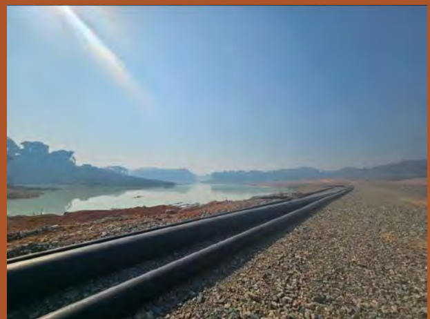
Barragem do Tocantinzinho
