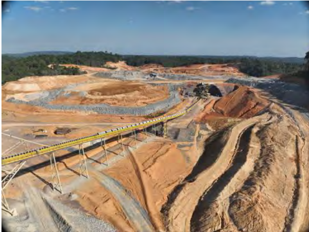
Planta de processos. Mina Tocantinzinho ao fundo
