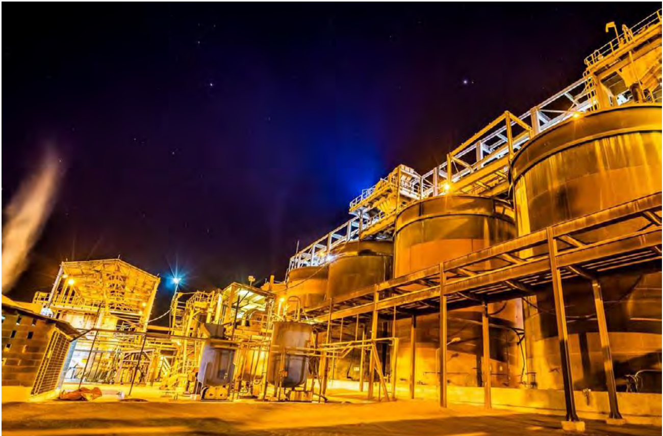
Instalações de Riacho dos Machados
