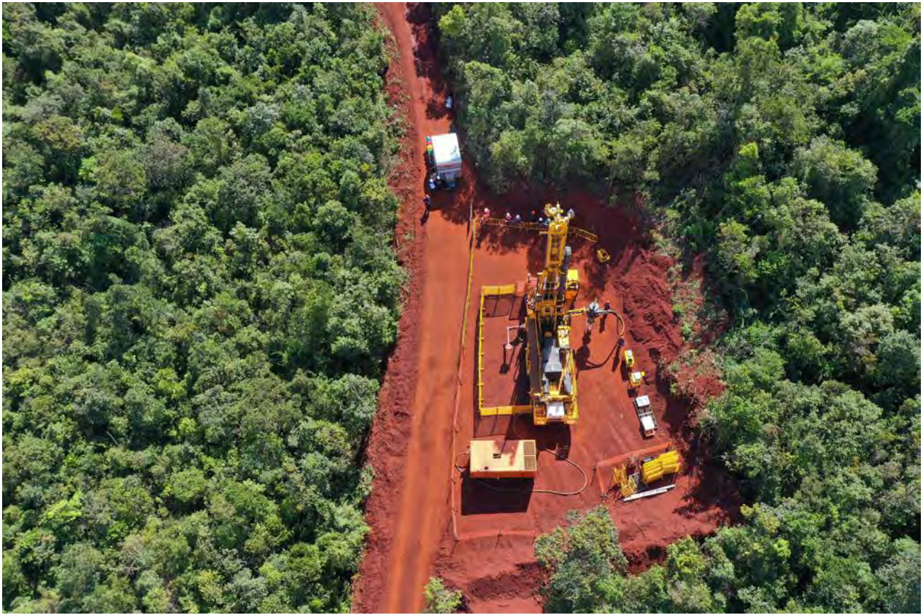
Frente de sondagem da Geosol
