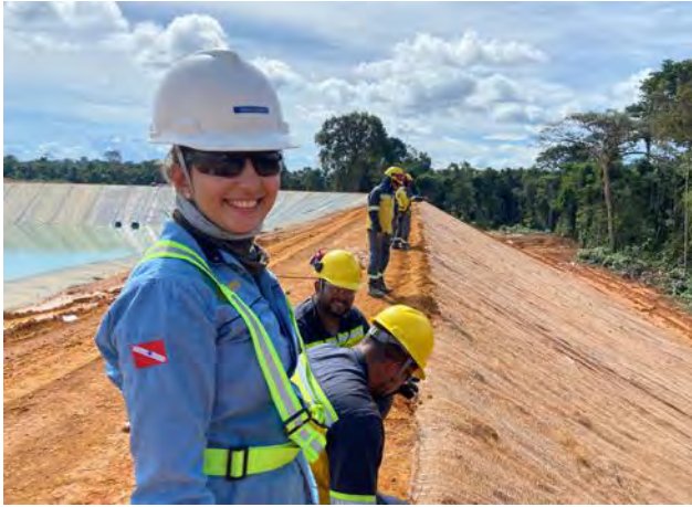
Disposição de biomantas na bacia de retenção
